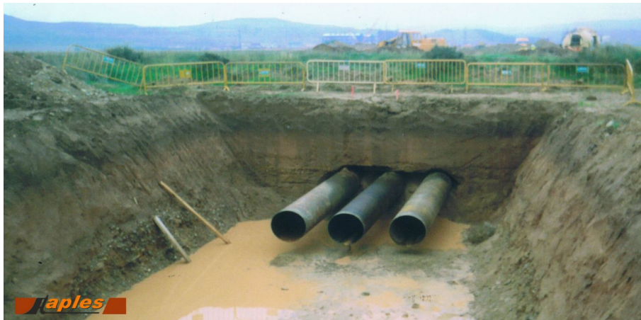
Tuberías hincadas desde el foso de ataque.
